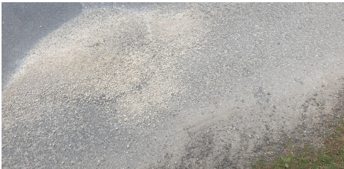
2. attēls Ceļa stāvoklis pēc “bedrīšu lāpīšanas”. Tuvplāns (Atoru attēls).
