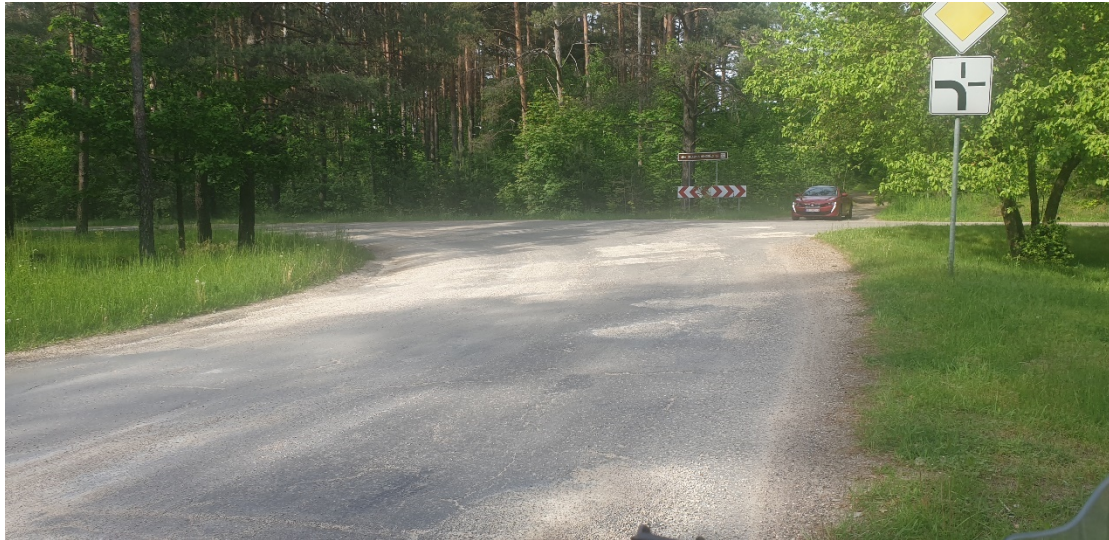
1. attēls Ceļa stāvoklis pēc “bedrīšu lāpīšanas” (Atoru attēls).
